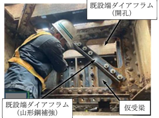
図-4 既設端ダイアフラムの改造
