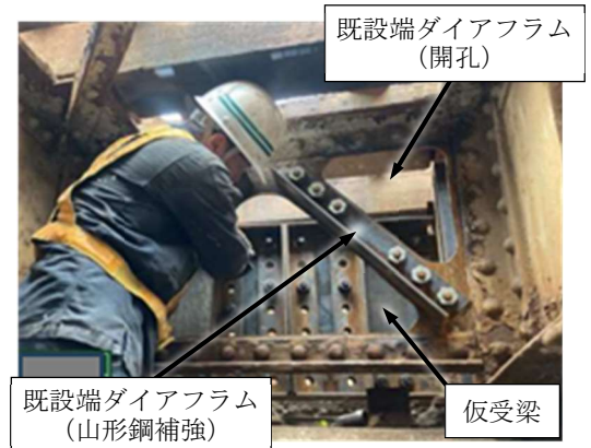
図-4 既設端ダイアフラムの改造
