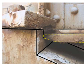
図-6 ソールプレート下面の摩耗状況
