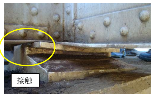
付図2 支承部の接触事例①
