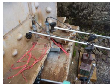
図14 計測器設置状況
